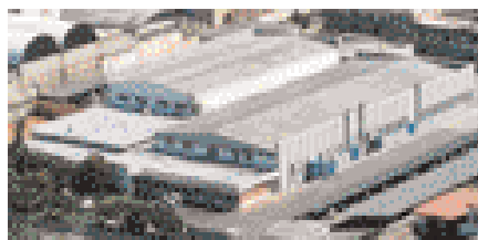
Permlastic è un prodotto made in Italy. Nella foto la sede Kerr Italia spa di Scafati (SA) dove nasce Permlastic.
